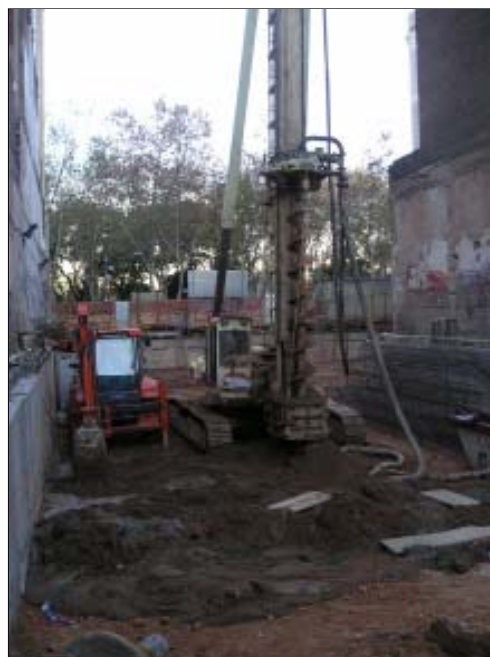
Excavació d'un dels pilotatges
