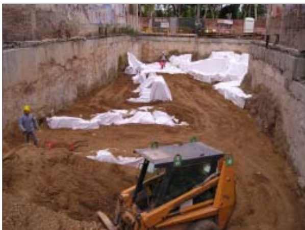
Rebliment amb terres del sector 1 i del carrer, des de l'oest
